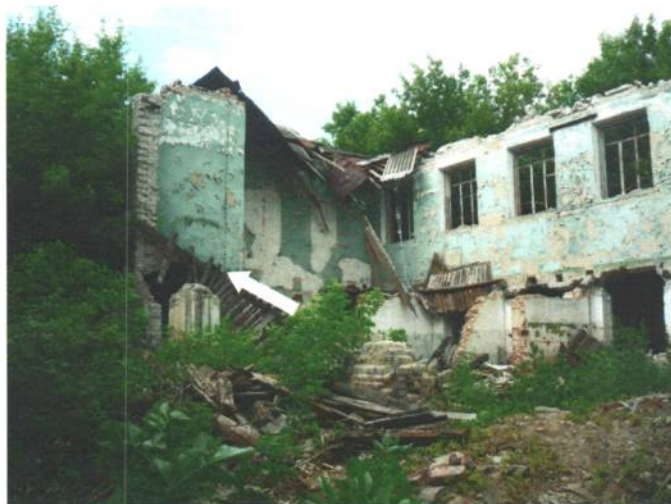
Фото 3. Объект культурного наследия регионального значения «Училище сельскохозяйственное (школа садоводства и огородничества)», Воронежская область, Рамонский район, Березово, ул. Мира, 6в Полное разрушение несущей ограждающей конструкции здания. Частичное разрушение внутренней поперечной несущей стены здания. Фото Хорошуновой О.И., 24 июня 2019 года
