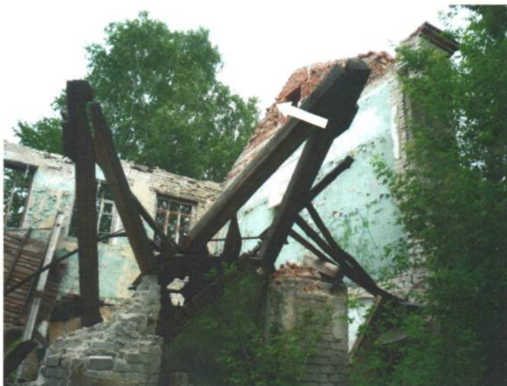
Фото 5. Объект культурного наследия регионального значения «Училище сельскохозяйственное (школа садоводства и огородничества)», Воронежская область, Рамонский район, с. Березово, ул. Мира, 6в Разрушение стропильной системы и покрытия кровли здания. Фото Хорошуновой О.И., 24 июня 2019 года
