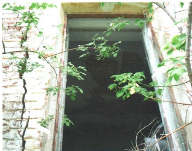
Фото 4. Объект культурного наследия регионального значения «Училище сельскохозяйственное (школа садоводства и огородничества)», Воронежская область, Рамонский район, с. Березово, ул. Мира, 6в Сквозная вертикальная трещины кирпичной кладки фасада здания. Фото Хорошуновой О.И., 24 июня 2019 года
