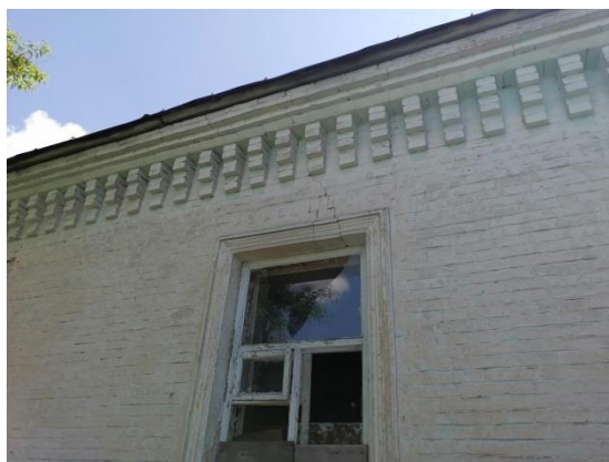
Фото 5. Объект культурного наследия регионального значения «Больница земская». Воронежская обл., г. Новохоперск, ул. Карла Маркса, 22. Отдельные локальные трещины, уходящие в оконные проемы шириной раскрытия до 6 мм.
