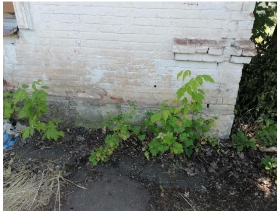
Фото 3. Объект культурного наследия регионального значения «Больница земская». Воронежская обл., г. Новохоперск, ул. Карла Маркса, 22. Отмостка отсутствует. Нарушение целостности, отслоение окрасочного слоя. Отмостка. Прорастание растительности.
