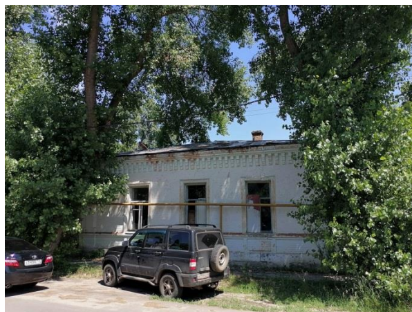
Фото 7. Объект культурного наследия регионального значения «Больница земская». Воронежская обл., г. Новохоперск, ул. Карла Маркса, 22. Крыша и кровля. Следы намокания венчающего карниза.
