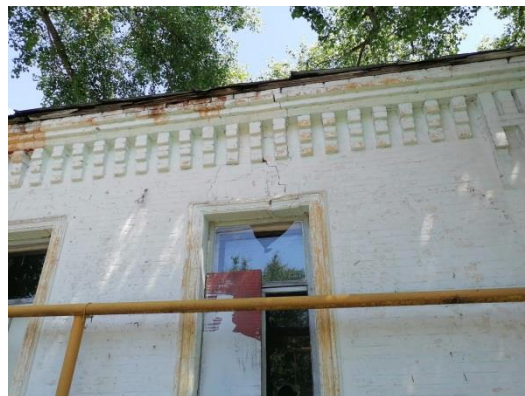
Фото 4. Объект культурного наследия регионального значения «Больница земская». Воронежская обл., г. Новохоперск, ул. Карла Маркса, 22. Следы намокания венчающего карниза. Отдельные локальные трещины, уходящие в оконные проемы шириной раскрытия до 6 мм.
