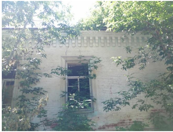
Фото 6. Объект культурного наследия регионального значения «Больница земская». Воронежская обл., г. Новохоперск, ул. Карла Маркса, 22. Изношенность окрасочного слоя. Отдельные локальные трещины, уходящие в оконные проемы шириной раскрытия до 6 мм.
