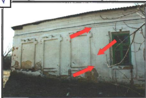
Фото 2. Объект культурного наследия регионального значения «Усадьба Нечаевых». Воронежская обл., Семилукский р-н, с. Терновое, ул. Терновская, 2. Вертикальные сквозные трещины в несущей стене. Фото Попова А.А., март 2016 года
