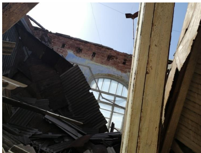
Фото 16. Объект культурного наследия регионального значения «Комплекс Высшего Начального училища. Учебный корпус», Воронежская область, Нижнедевицкий район, с. Нижнедевицк, ул. Луначарского, д. 8. Обрушение чердачного перекрытия и конструкции крыши.
