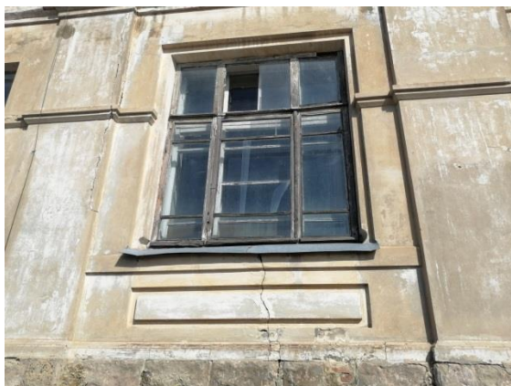
Фото 9. Объект культурного наследия регионального значения «Комплекс Высшего Начального училища. Учебный корпус», Воронежская область, Нижнедевицкий район, с. Нижнедевицк, ул. Луначарского, д. 8. Стены. Главный фасад. Отдельные трещины в кирпичной кладке, уходящие в оконные проемы, шириной раскрытия до 5 мм.
