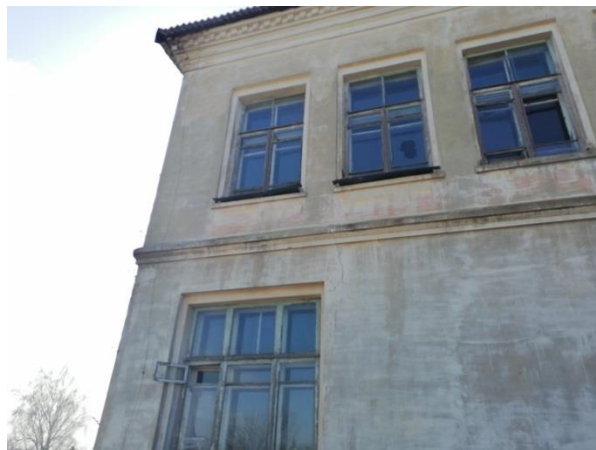
Фото 10. Объект культурного наследия регионального значения «Комплекс Высшего Начального училища. Учебный корпус», Воронежская область, Нижнедевицкий район, с. Нижнедевицк, ул. Луначарского, д. 8. Стены. Дворовый фасад. Отдельные трещины в кирпичной кладке, уходящие в оконные проемы, шириной раскрытия до 5 мм.
