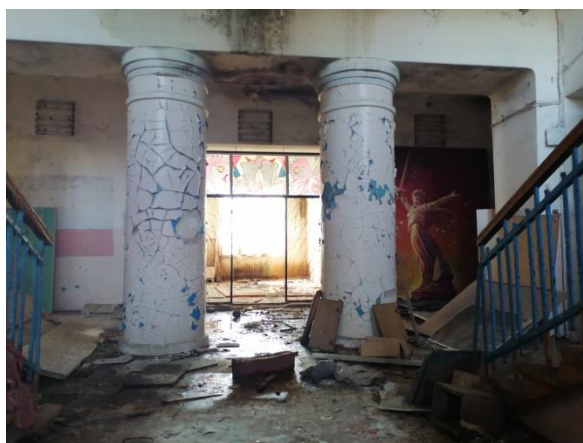
Фото 13. Объект культурного наследия регионального значения «Комплекс Высшего Начального училища. Учебный корпус», Воронежская область, Нижнедевицкий район, с. Нижнедевицк, ул. Луначарского, д. 8. Стены, колонны. Следы намокания, нарушение целостности, отслоение штукатурно-окрасочного слоя.
