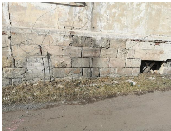
Фото 7. Объект культурного наследия регионального значения «Комплекс Высшего Начального училища. Учебный корпус», Воронежская область, Нижнедевицкий район, с. Нижнедевицк, ул. Луначарского, д. 8. Цоколь. Утрата окрасочного слоя; выветривание шовного раствора; выбоины, сколы в каменных плитах.
