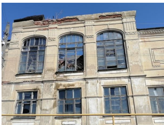
Фото 8. Объект культурного наследия регионального значения «Комплекс Высшего Начального училища. Учебный корпус», Воронежская область, Нижнедевицкий район, с. Нижнедевицк, ул. Луначарского, д. 8. Стены. Главный фасад. Следы намокания поверхности стен; нарушение целостности, растрескивание, фрагментарная утрата штукатурно-окрасочного слоя.
