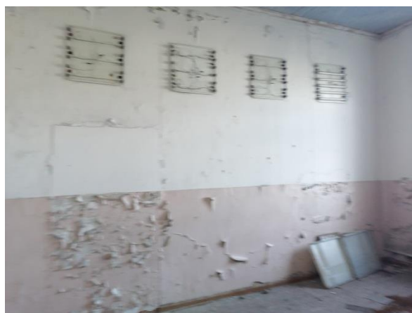
Фото 14. Объект культурного наследия регионального значения «Комплекс Высшего Начального училища. Учебный корпус», Воронежская область, Нижнедевицкий район, с. Нижнедевицк, ул. Луначарского, д. 8. Стены, колонны. Нарушение целостности, отслоение штукатурно-окрасочного слоя.
