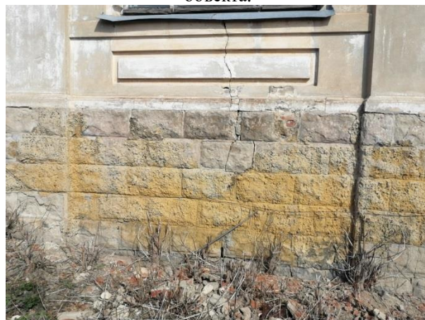
Фото 4. Объект культурного наследия регионального значения «Комплекс Высшего Начального училища. Учебный корпус», Воронежская область, Нижнедевицкий район, с. Нижнедевицк, ул. Луначарского, д. 8. Цоколь. Изношенность окрасочного слоя. Отмостка отсутствует, наличие растительности в непосредственной близости от объекта.
