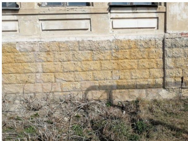
Фото 4. Объект культурного наследия регионального значения «Комплекс Высшего Начального училища. Учебный корпус», Воронежская область, Нижнедевицкий район, с. Нижнедевицк, ул. Луначарского, д. 8. Цоколь. Изношенность окрасочного слоя. Отмостка отсутствует, наличие растительности в непосредственной близости от объекта.
