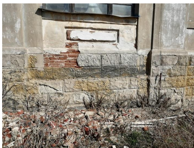
Фото 6. Объект культурного наследия регионального значения «Комплекс Высшего Начального училища. Учебный корпус», Воронежская область, Нижнедевицкий район, с. Нижнедевицк, ул. Луначарского, д. 8. Цоколь. Изношенность, частичная утрата окрасочного слоя, выбоины, сколы в каменных плитах; отпадение отдельных плит. Отмостка отсутствует, наличие растительности в непосредственной близости от объекта.
