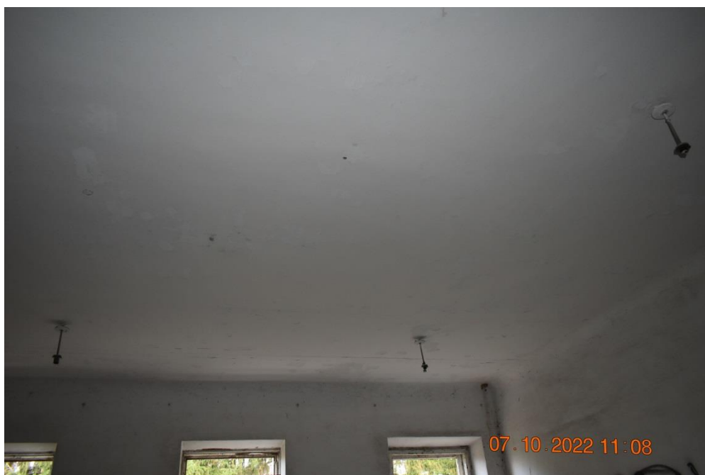
Фото 11. Объект культурного наследия «Дача Башкирцевых». Воронежская область, г. Семилуки, ул. Дача, 1а. Потолки.
