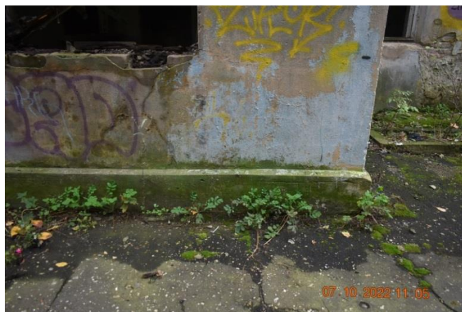
Фото 5. Объект культурного наследия «Дача Башкирцевых». Воронежская область, г. Семилуки, ул. Дача, 1а. Цоколь и отмостка.
